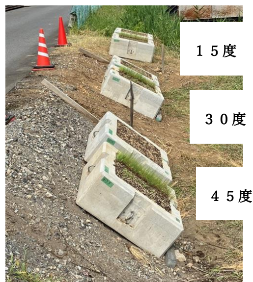
図-12 傾斜地への設置状況
